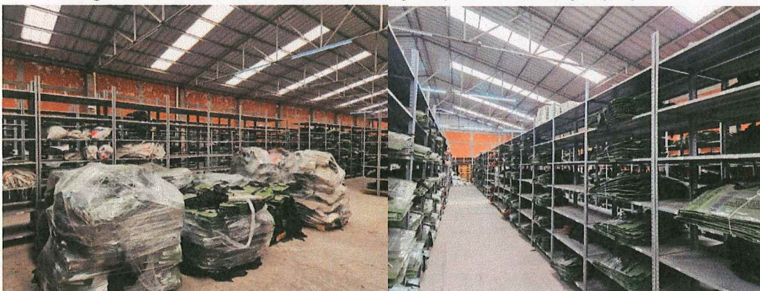
Imagen 10. Avance en la rehabilitación y limpieza de las cajas paquete electoral
